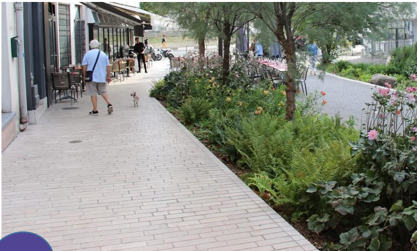
Exemple de revêtements en dalles calcaires (pour la place de l'Aquapol)
