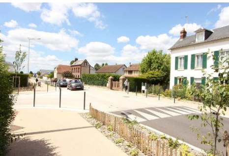
Création d'un plateau traversant
