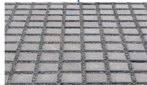
Pavage avec joints drainants
