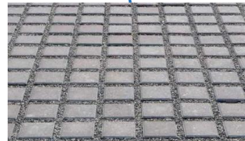
Pavage avec joints drainants
