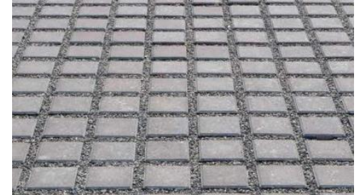
Pavage avec joints drainants
