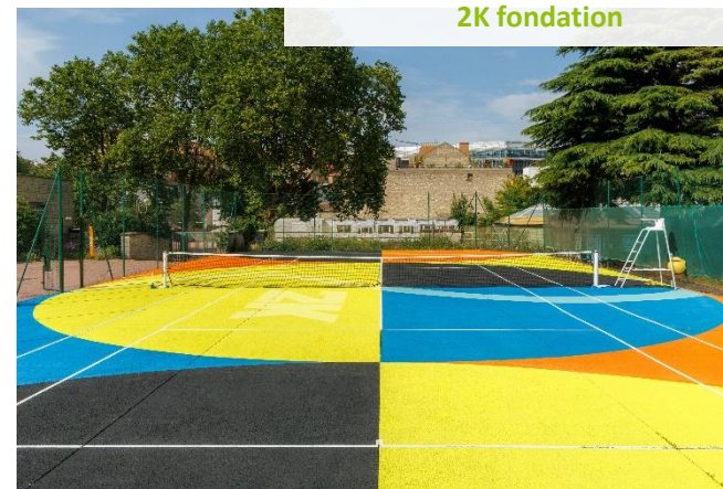
Rénovation d'un court de tennis par 2K fondation
