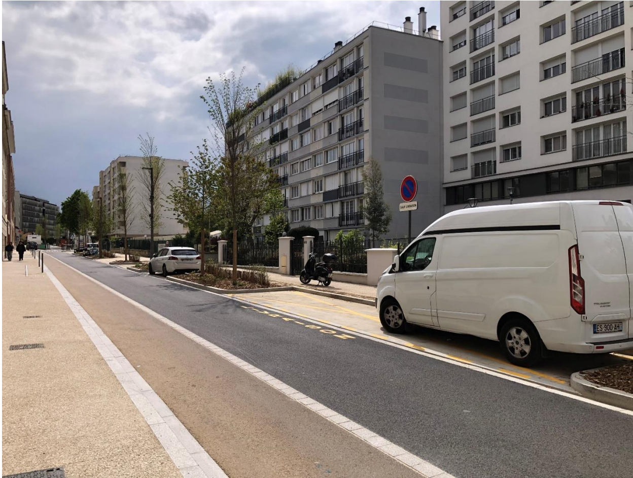
Bande cyclable en sens inverse en enrobés beiges
