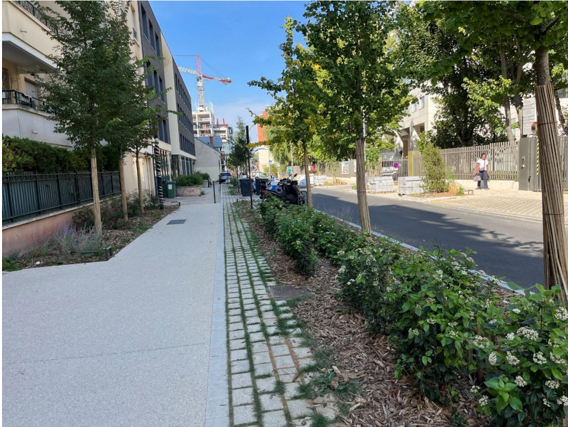
Surlargeur de trottoir en pavés granit à joint enherbés
