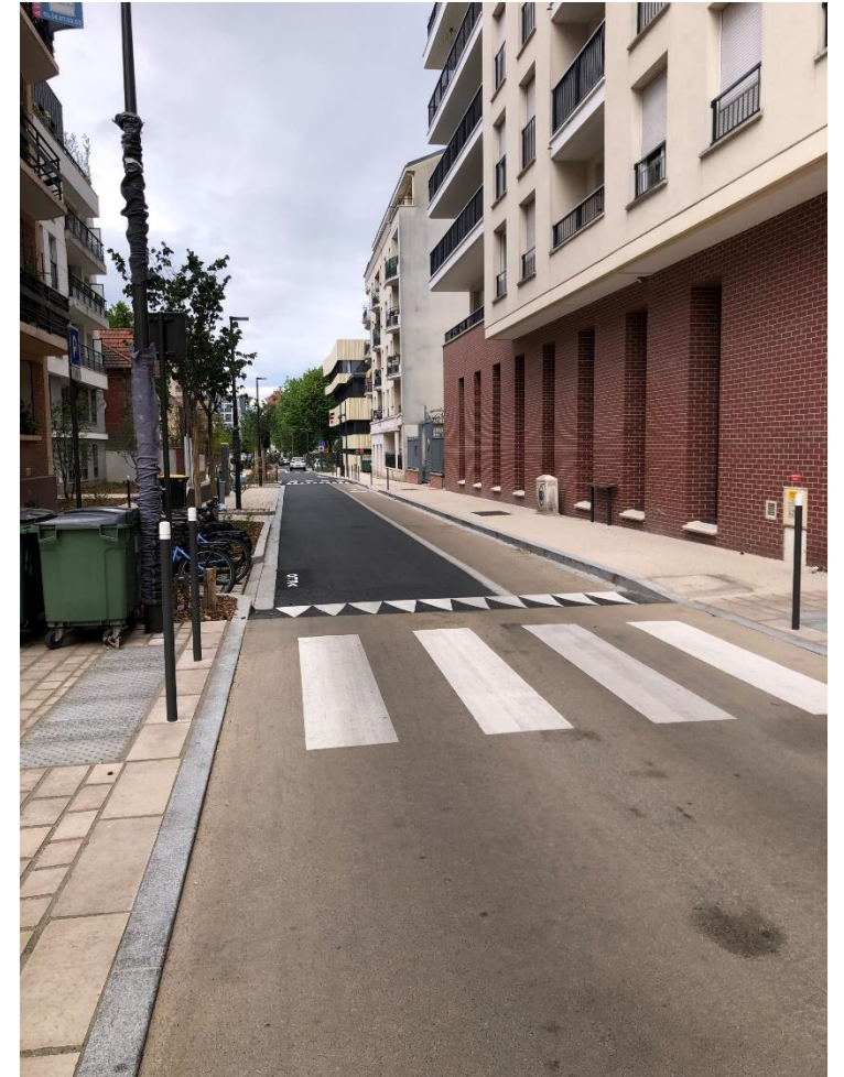
Trottoir en dalles calcaires et plateau surélevé en enrobés beiges
