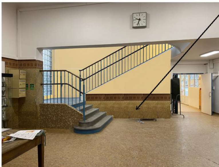
Création d'une cloison et d'un espace boîtes aux lettres au dos
